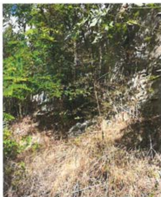
Rivassel / La Redorte / Berge instable
