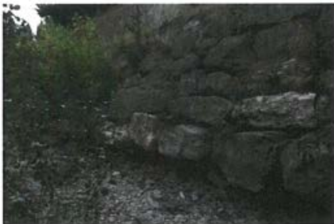
Argent Double / Caunes / Enrochements non liaisonnés sous cavès
