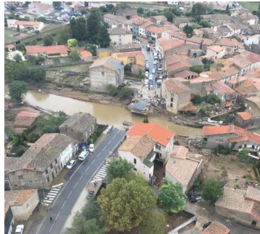
Vues du pont de la RD118 sur le Trapel à Villegailhenc le lendemain de la crue
