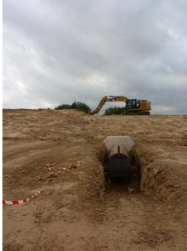
Après pose puits
