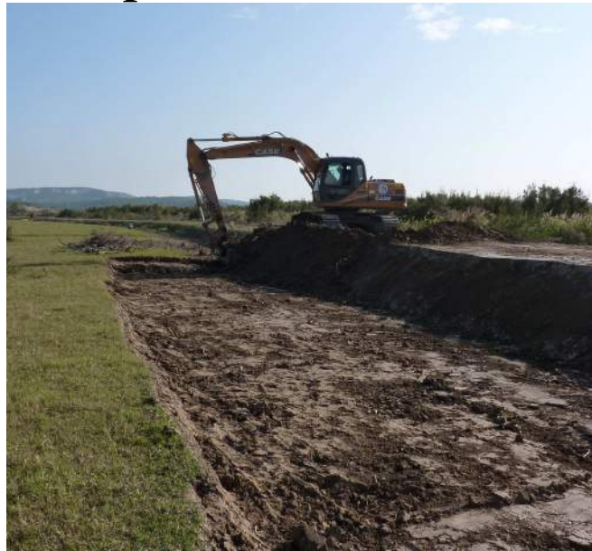
Reprise digue de Tournebelle
