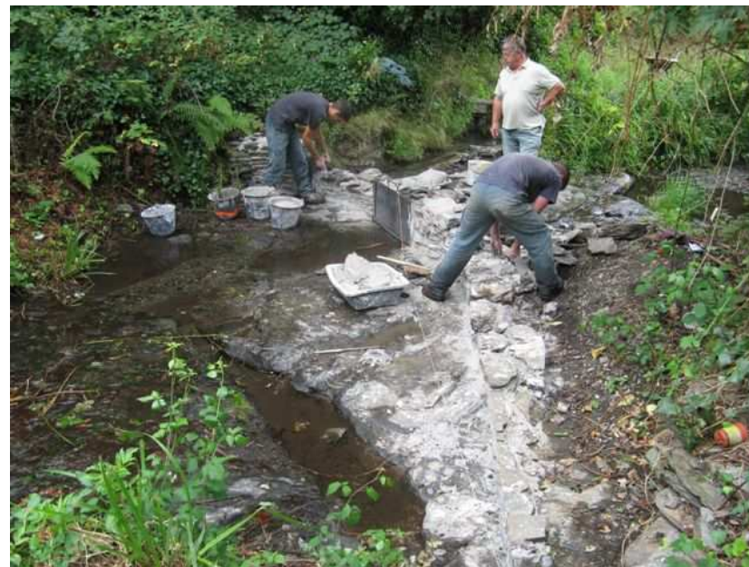
Restauration patrimoine bâti au Mas Cabardès
