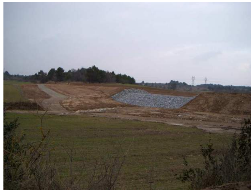
Finalisation de l'Ouvrage
