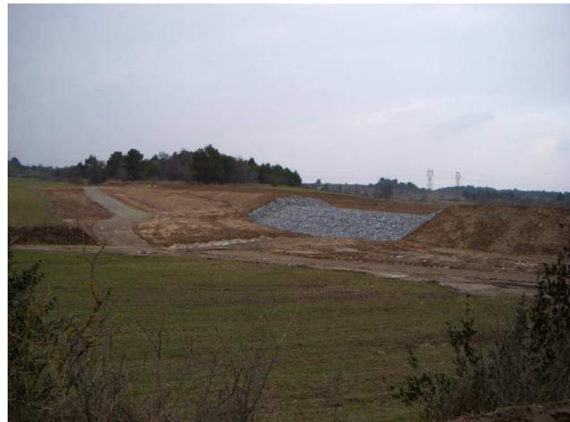
Finalisation de l'Ouvrage
