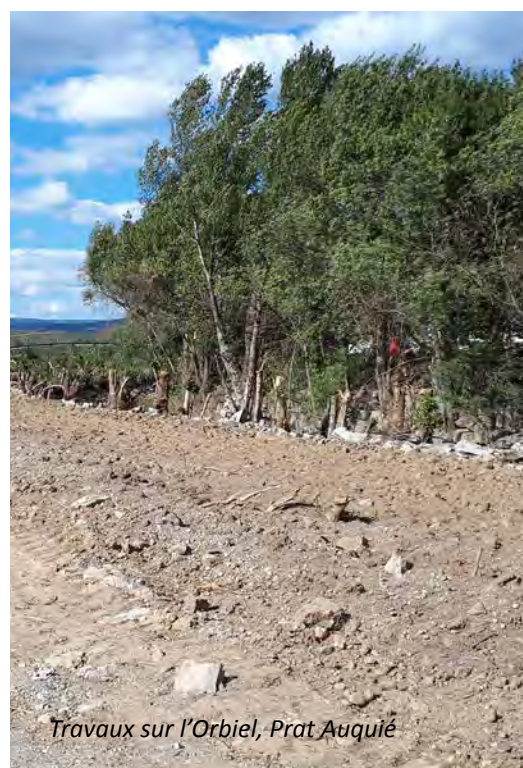
Arasement du seuil, Prat Auquié
