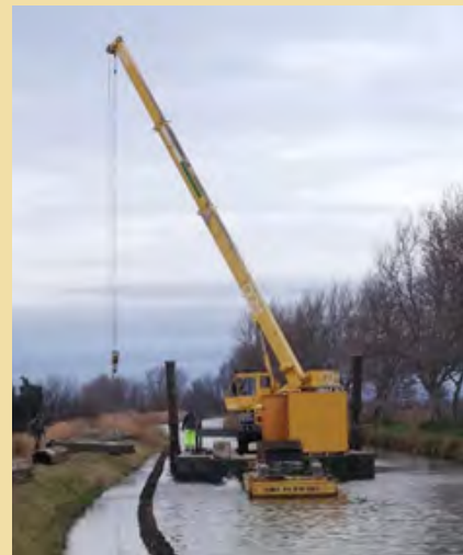
Pose de palplanches (Robine - photo VNF)
