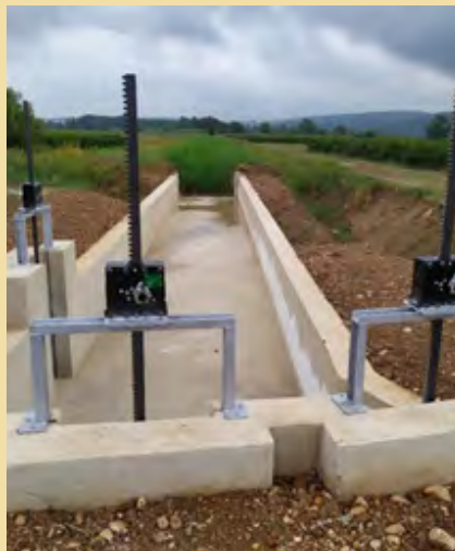
Reprise d'ouvrage (contrat Robine - photo ASEAUDE)
