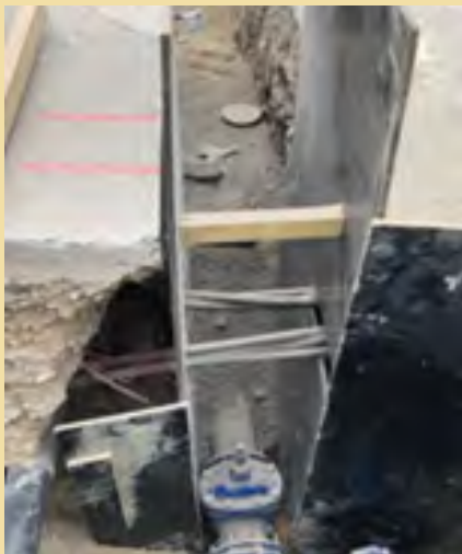
Travaux AEP (photo Grand Narbonne)
