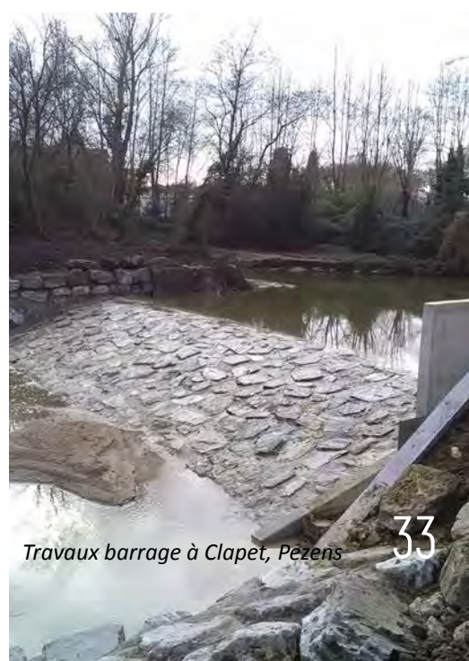
Travaux sur l'Orbiel, Prat Auquié
